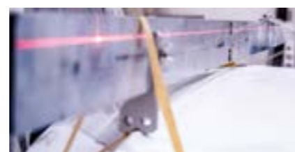
Выравнивание продольного бруса с помощью лазера
