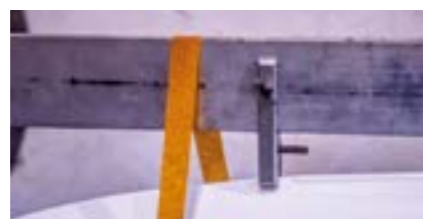
Установка продольного бруса на станции 8
